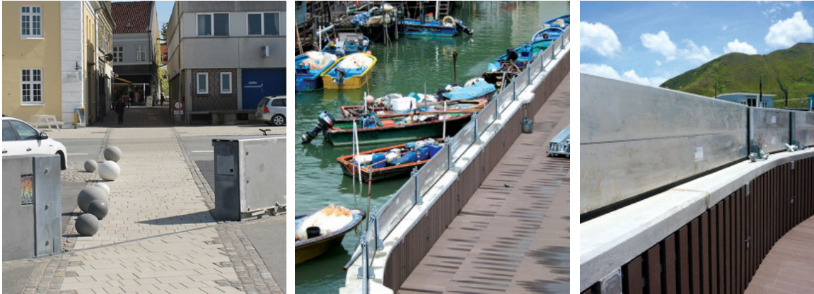
Foto: Eksempler på stormflodssikring med murværk i beton eller træ. Eksempel på rulleport i aluminium, sådan at adgang til søsætningsrampe og øvrige havneområder kan bevares. Eksempel på mobil sikring med stålflagevæg.
